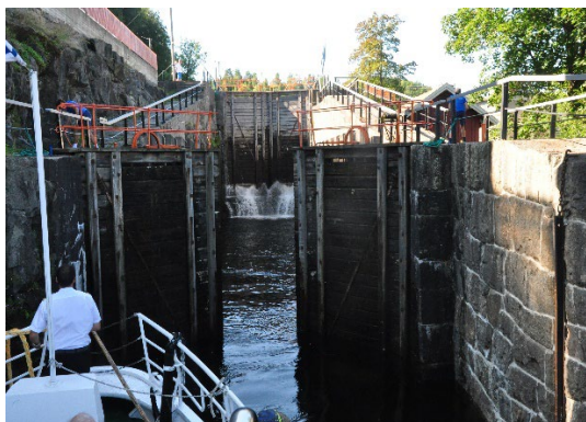
Eit kammer i ei av slusene. Flott steinarbeid mm i 5 år.
